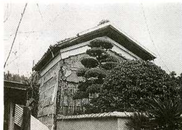
写真-4 損傷のみで倒壊しなかった土蔵
