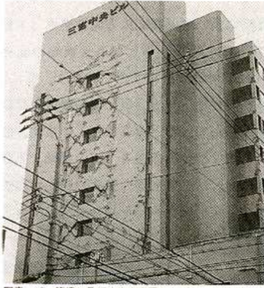
写真一五 筋違に及ぼす力を表現したビル ×印に注意
