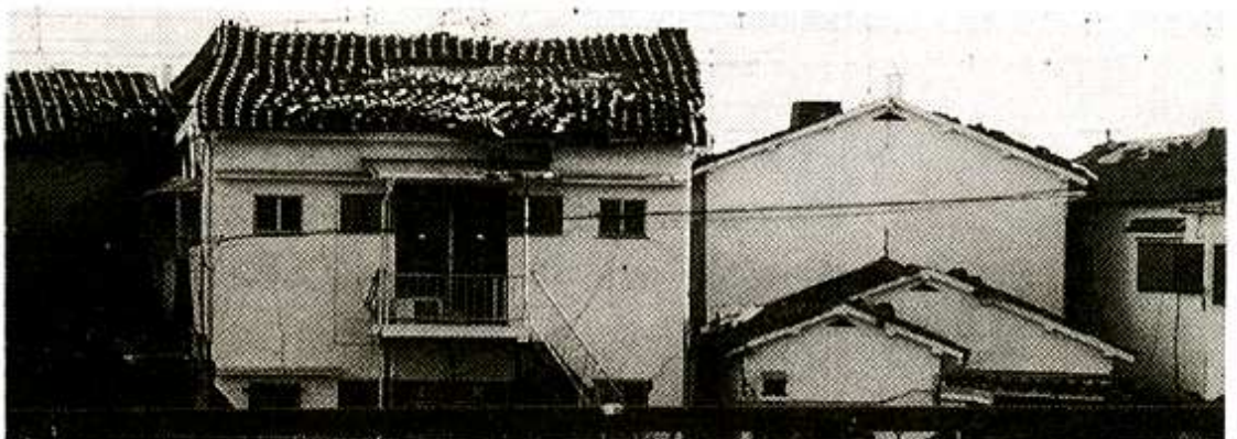
写真-18 車窓からの屋根 瓦の動きに注意
