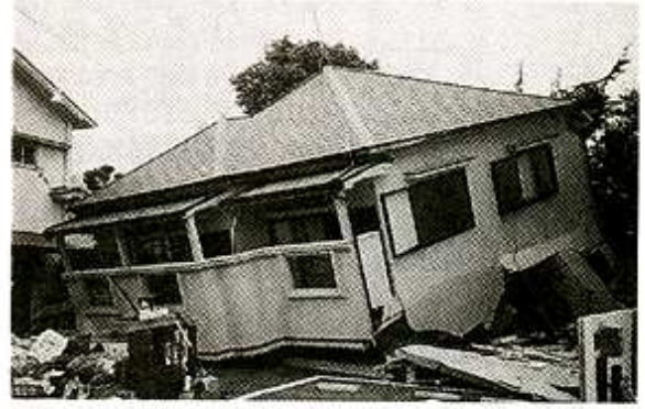
写真一〇 手抜き工事 新しいのに1階が潰れた
