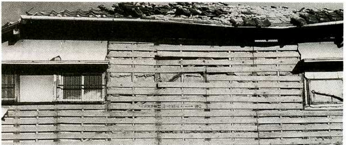
写真一六 筋違を45度に入れた古い家 外壁は15年くらい前に土塗壁ヘラス板を張ってモルタル下地漆喰塗りをしている
