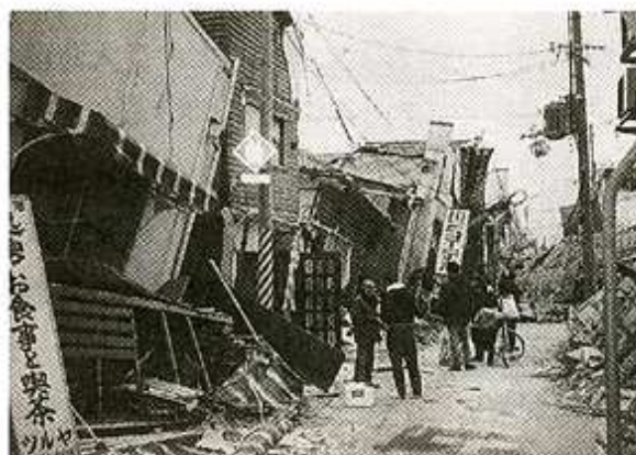
写真-7 南北方向の倒壊現場
