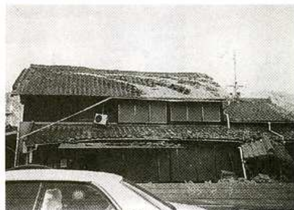
写真-3 100年以上の建物右側の近年増築箇所は倒壊している
