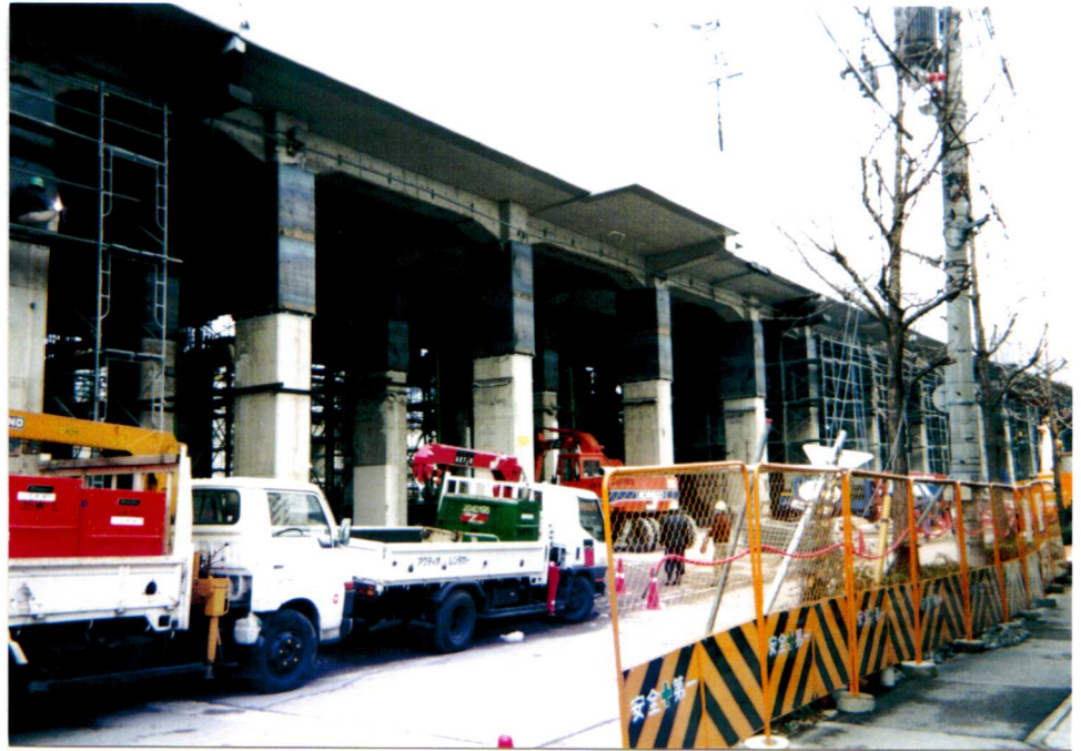
J R 損傷高架の 補強工事 写真⑤
