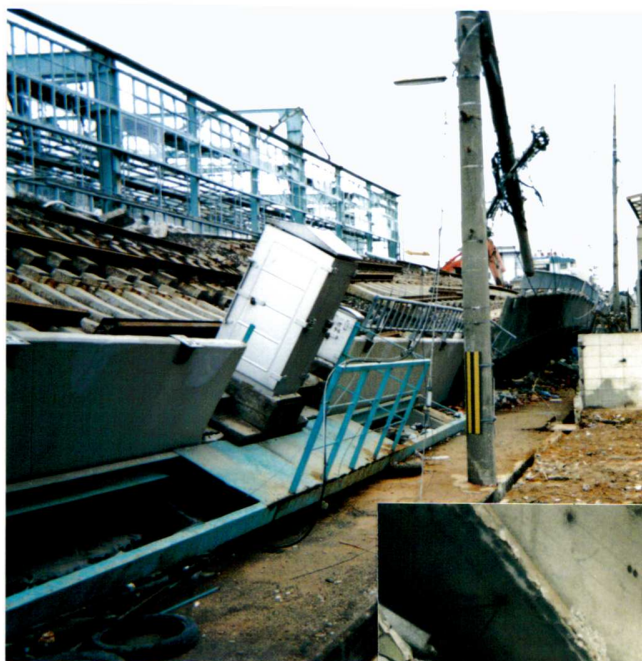
横倒しとなった 阪神電鉄操車場 写真③
