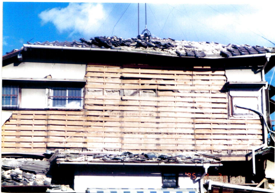
45度に入れられた筋違
